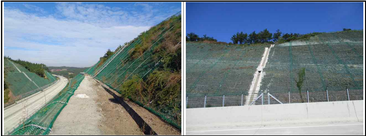
【그림 64.3.3】 배수시설 전경
